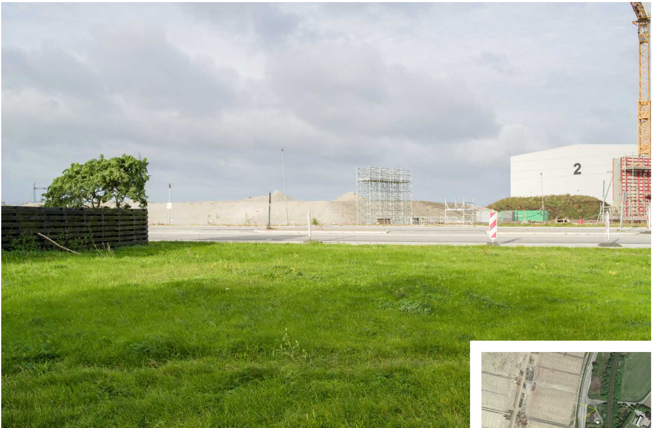
5 Brovejen / Maagevej Eksisterende forhold
