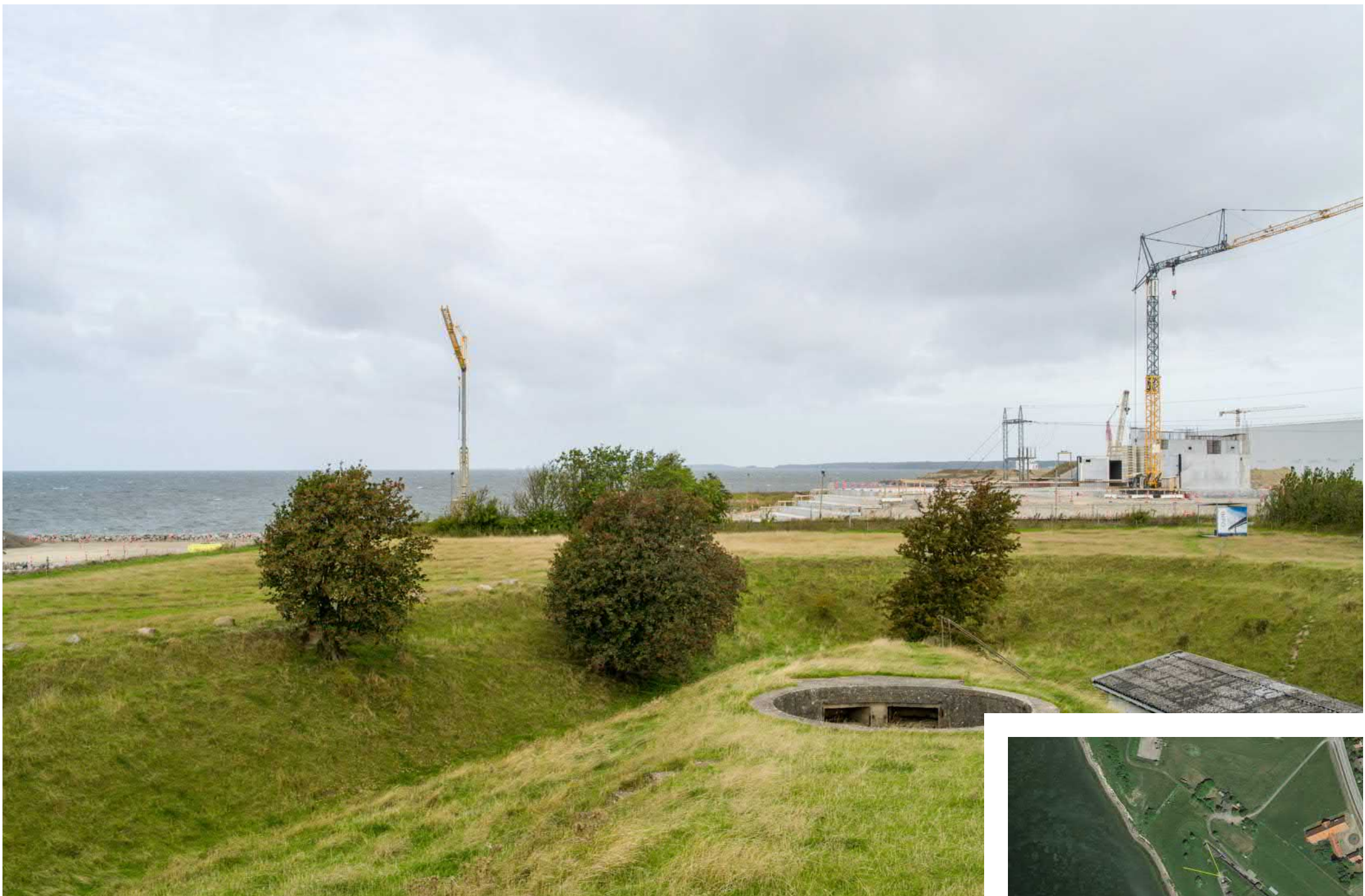
6 Masnedøfortet Eksisterende forhold
