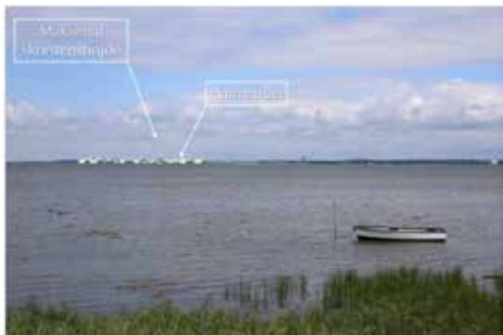
Figur 4-14 Fremtidige forhold set fra Orehoved med fuld udbygning af havnen.
