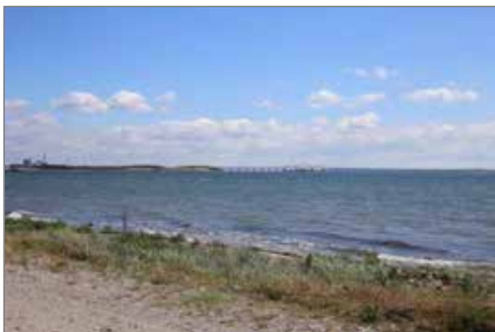
Figur 4-3 Eksisterende forhold set fra Badevej. Her ses Masnedø til venstre i billedet og den eksisterende Masnedøbro til højre i billedet.
