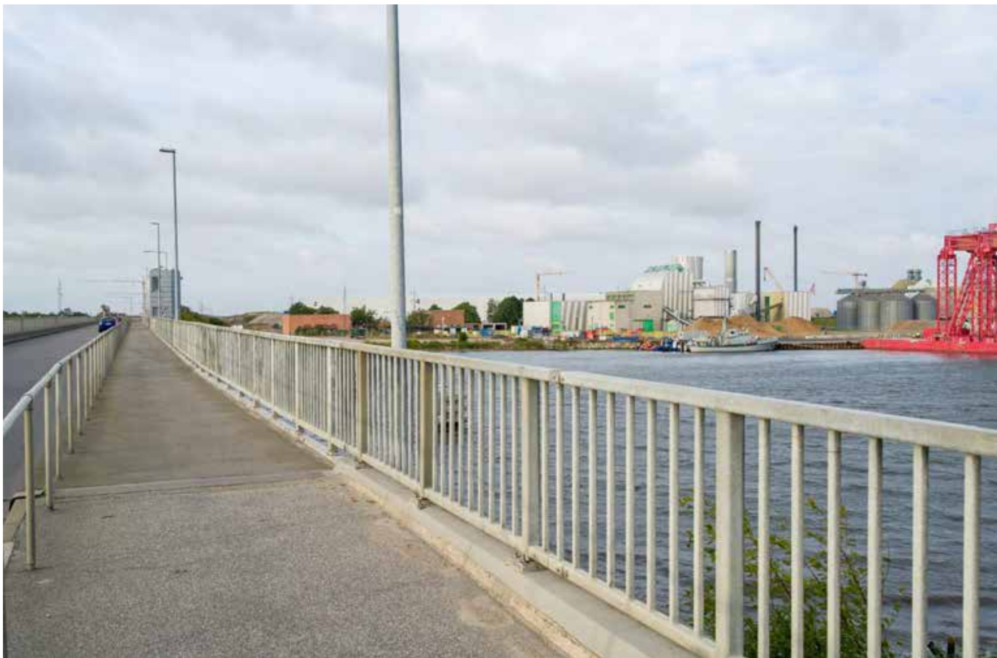
Visualisering 3 – Eksisterende forhold fra Masnedsundbroen.
