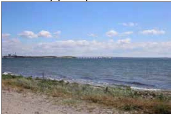
Figur 4-3 Eksisterende forhold set fra Badevej. Her ses Masnedø til venstre i billedet og den eksisterende Masnedsundbro til højre i billedet.
