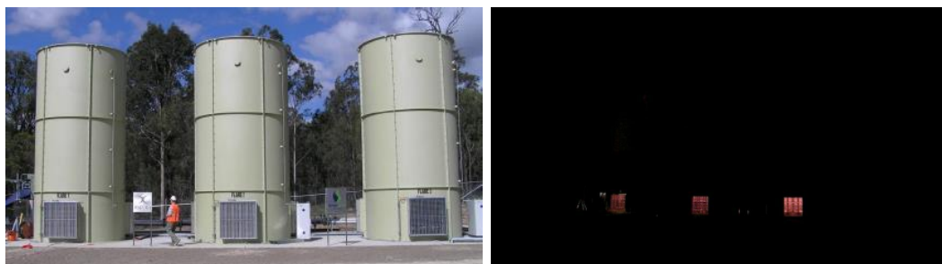
Figur 9-19. Illustration af nød anlæg med 3 fakler med indvendig brænder i dags- og natte-lys.
