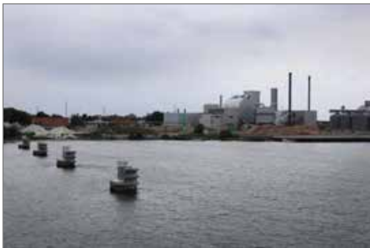
Figur 4-9 Eksisterende forhold på Masnedø set fra Brovejen. Midt/til højre i billedet ligger Masnedøværket og til højre ses kornsiloanlægget hos DLG.
