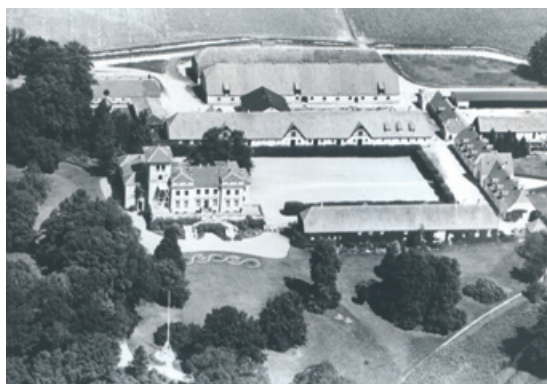
Forrest i anlægget ses den hovedbygning, der blev opført i 1855 og nedrevet i 1984. Luftfoto fra slutningen af 1930'erne.
