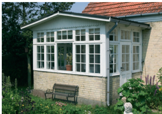
Eksempel på en nydelig, lille veranda på Grønsundvej 282 i Damsholte. Vinduernes små ruder mellem smalle sprosser giver bygningen en spinkel og let karakter, som står i god kontrast til det murede hus. De to facadekarakterer fremhæver hinanden.
