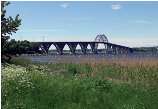
Dronning Alexandrines bro er en klassisk buebro med buer både over og under vejbanen. Broen blev indviet i 1943.
