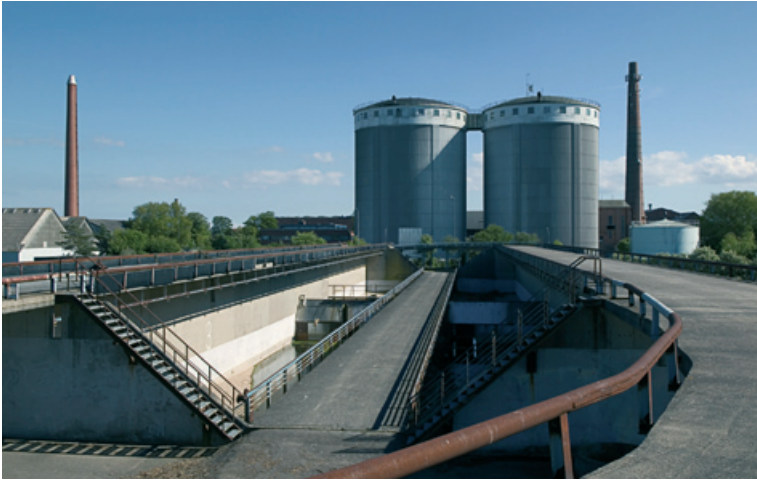
1 Bag Sukkerfabrikkens røde bygninger spiller siloerne sammen med rampeanlægget, hvor lastbilerne læssede roerne af.
