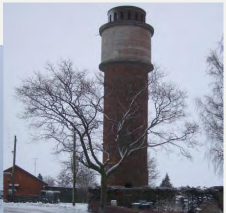
Vandtårn på Skolemærksvej
