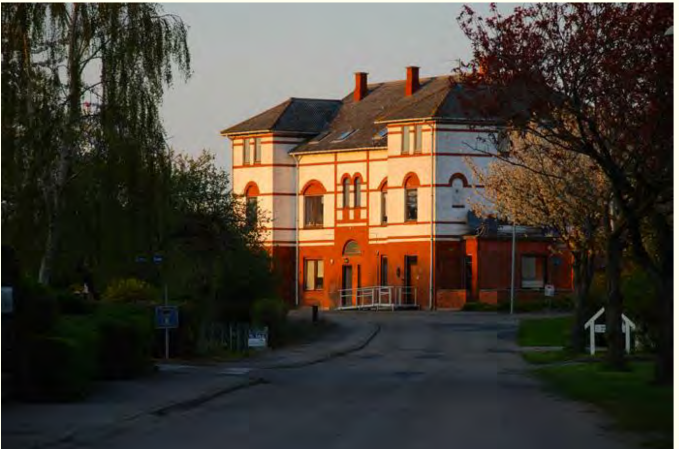
Den tidligere stationsbygning
