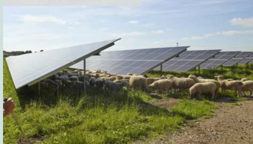
Foto: eksempel på solceller på faste stativer
