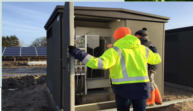
Tekniker installerer transformer
