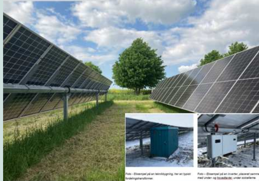
Foto: eksempel på solceller på faste stativer
